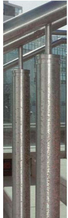
Rostande järnföroreningar på rostfritt stål skämmer utseendet på den slutliga produkten. Att få bort dem kan vara både tidsödande och dyrbart.
